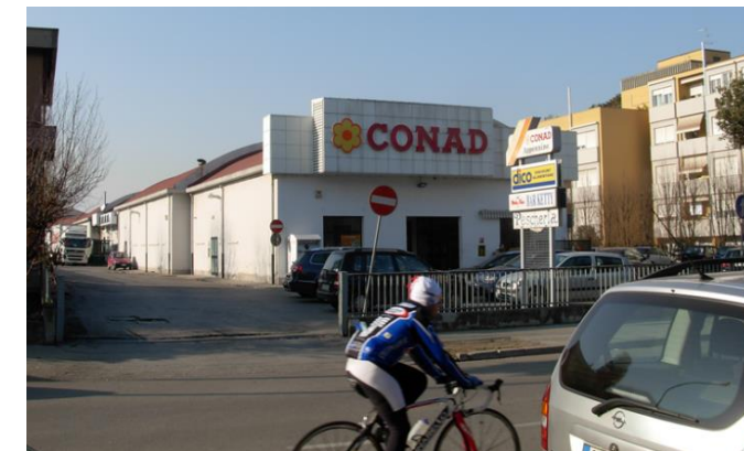
EDIFICIO 2: EX INCUBATOIO. Il complesso è una tipologia "in linea" con struttura mista in muratura e cemento armato con tamponamenti laterali in intonacati e tinteggiati; il tutto sormontato, nella porzione principale, da una copertura voltata con finitura superficiale in guaina ardesiata, mentre nella porzione di fabbricato ad ovest è presente una copertura a falde in laterizio.
