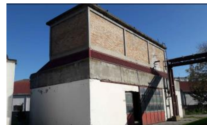
EDIFICIO 7: locale tecnico ex centrale termica a gasolio. Il fabbricato è di forma rettangolare, con struttura in cemento armato travi-pilastri, tamponamenti in laterizio e copertura piana.
