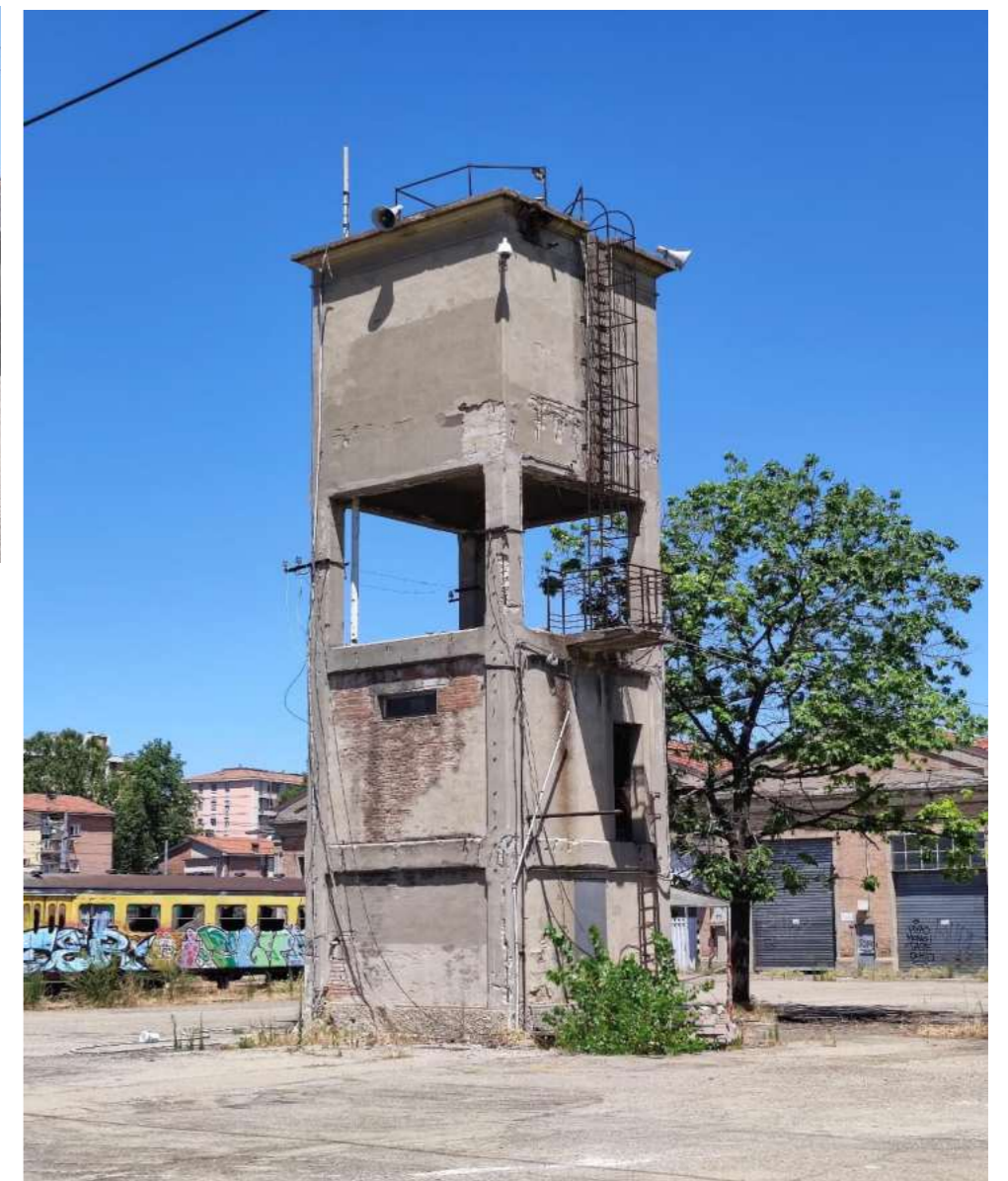
10 – Torre piezometrica, foglio 175, part. 201
