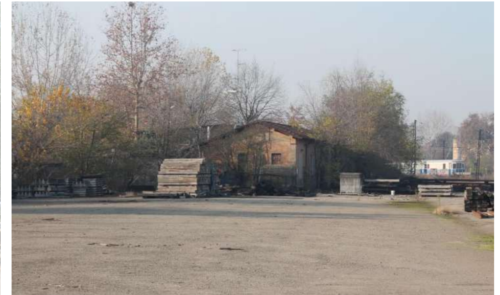
8 – Fabbricato ex circolo ferroviario, foglio 175, part. 204
