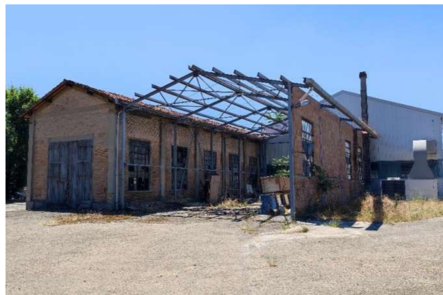
14 – Fabbricato ex lavaggio, foglio 175, part. 197
