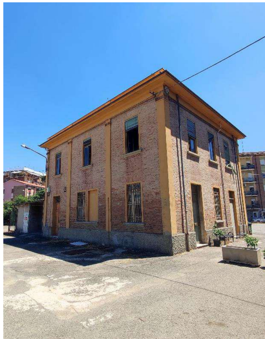
12 – Fabbricato spogliatoio, foglio 175, part. 199
