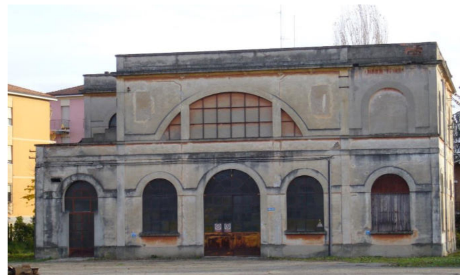
Figura 20 – Sottostazione elettrica (SSE), foglio 175, part. 205
