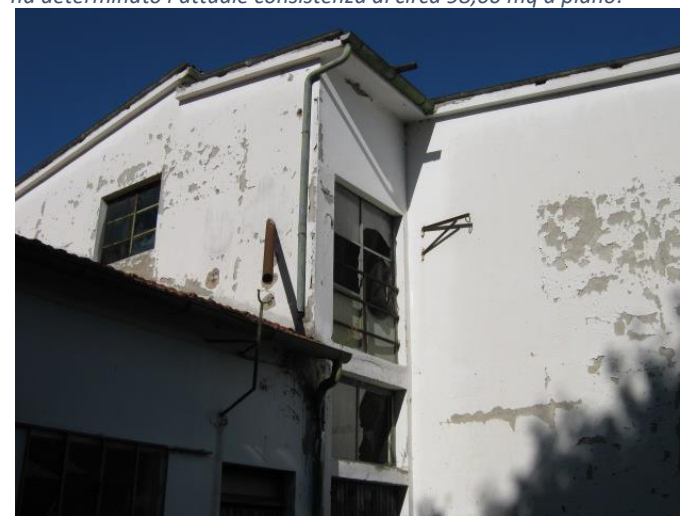
Figura 41. Fabbricato C - magazzini, locali allevamento, spogliatoi, servizi, mensa. Edificio in muratura di mattoni e solaio in laterocemento con manto di copertura in cotto, costituito da tre corpi di fabbrica per una superficie complessiva di circa 735,00 mq al piano terra, 560,00 mq al piano primo.
