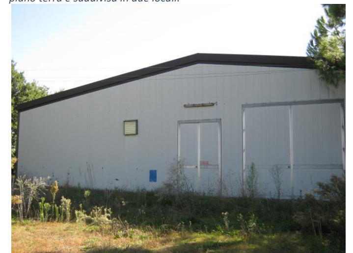
Figura 44. Fabbricato D - capannone zootecnico. Costruzione con struttura portante in acciaio, costituita da pilastri e travi reticolari con arcarecci di copertura, il tutto opportunamente coibentato e tutt'ora in buono stato di conservazione, per una superficie lorda complessiva di circa 1.680,00 mq
