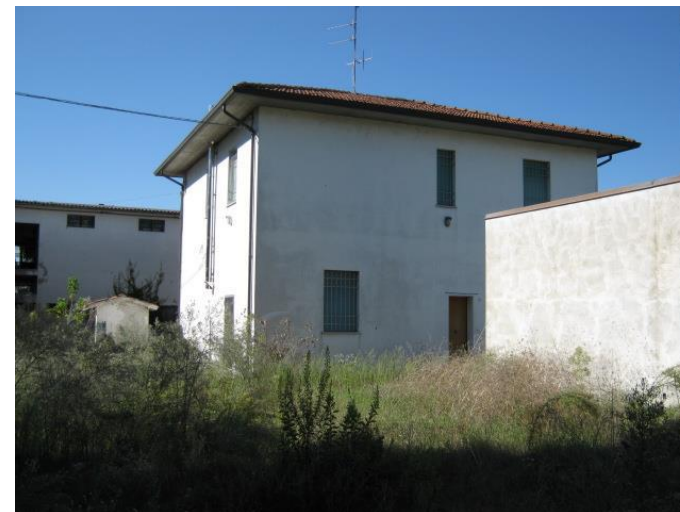
Figura 40. Fabbricato A - palazzina uffici e abitazione del custode. Edificio in muratura e cemento armato originariamente costituito dal solo piano terra, poi oggetto di un intervento di sopraelevazione che ne ha determinato l'attuale consistenza di circa 98,00 mq a piano.
