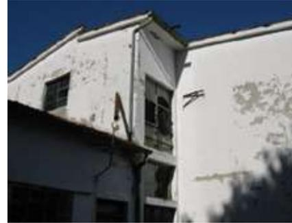
Figura 40. Fabbricato C - magazzini, locali allevamento, spogliatoi, servizi, mensa. Edificio in muratura di mattoni e solaio in laterocemento con manto di copertura in cotto, costituito da tre corpi di fabbrica per una superficie complessiva di circa 735,00 mq al piano terra, 560,00 mq al piano primo.
