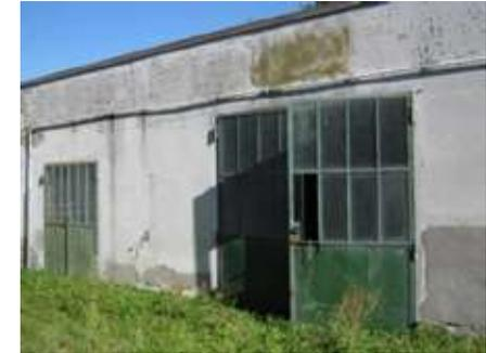
Figura 42. Fabbricato B - cantina e ricovero attrezzi. Piccolo edificio costruito in muratura di mattoni con copertura piana in laterocemento, della superficie lorda complessiva di circa 75,00 mq, disposta sul solo piano terra e suddivisa in due locali.
