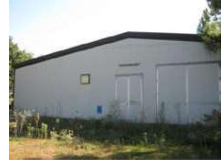
Figura 43. Fabbricato D - capannone zootecnico. Costruzione con struttura portante in acciaio, costituita da pilastri e travi reticolari con arcarecci di copertura, il tutto opportunamente coibentato e tutt'ora in buono stato di conservazione, per una superficie lorda complessiva di circa 1.680,00 mq.
