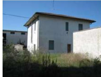
Figura 39. Fabbricato A - palazzina uffici e abitazione del custode. Edificio in muratura e cemento armato originariamente costituito dal solo piano terra, poi oggetto di un intervento di sopraelevazione che ne ha determinato l'attuale consistenza di circa 98,00 mq a piano.
