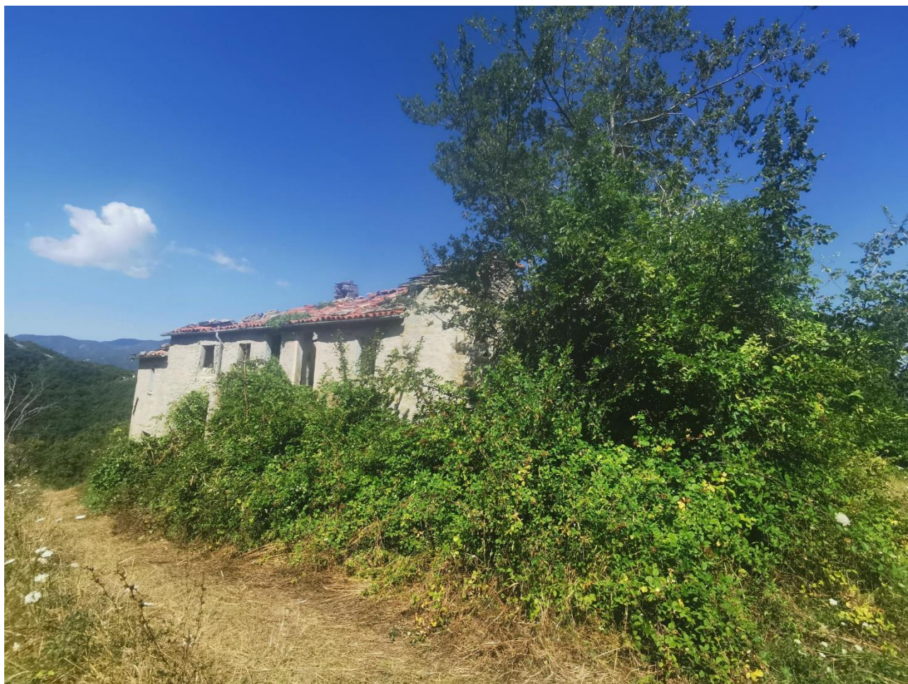
Figura 4_Il prospetto sud del fabbricato principale visto da sud-est
