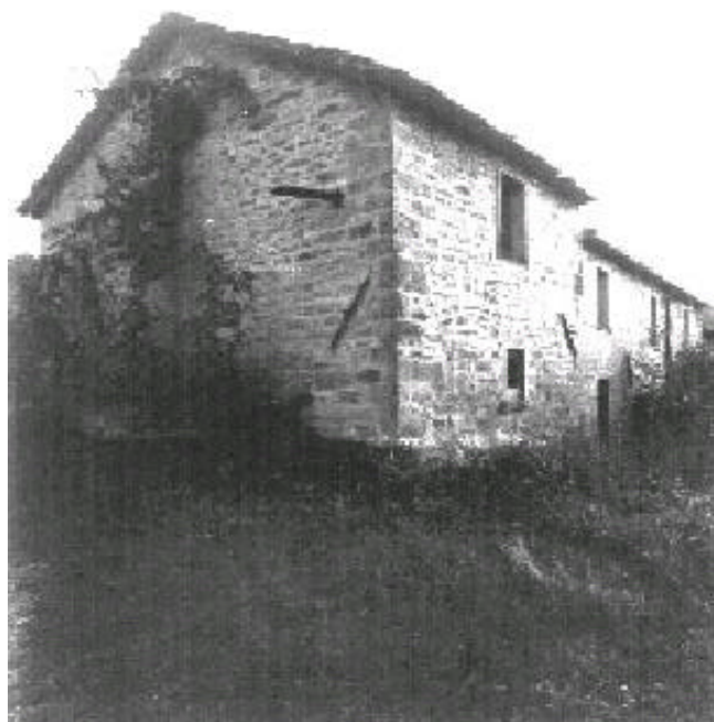
Vista da nord est, prospetto a valle, dalla strada di accesso.
