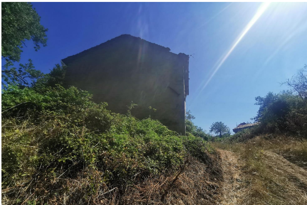
Figura 6_ Il prospetto ovest del fabbricato principale
