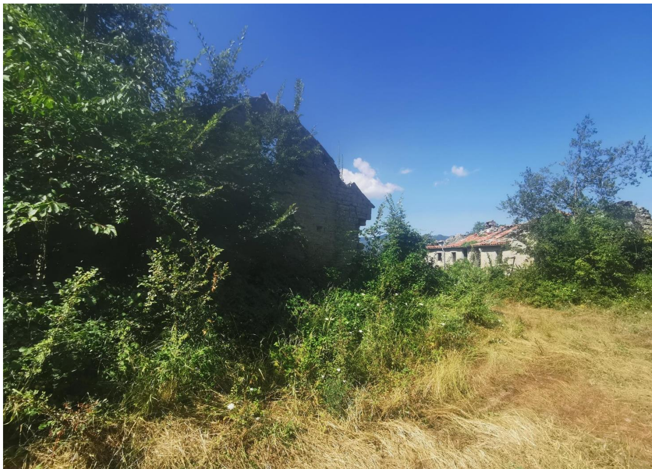
Figura 7_In primo piano il magazzino e sullo sfondo il fabbricato principale
