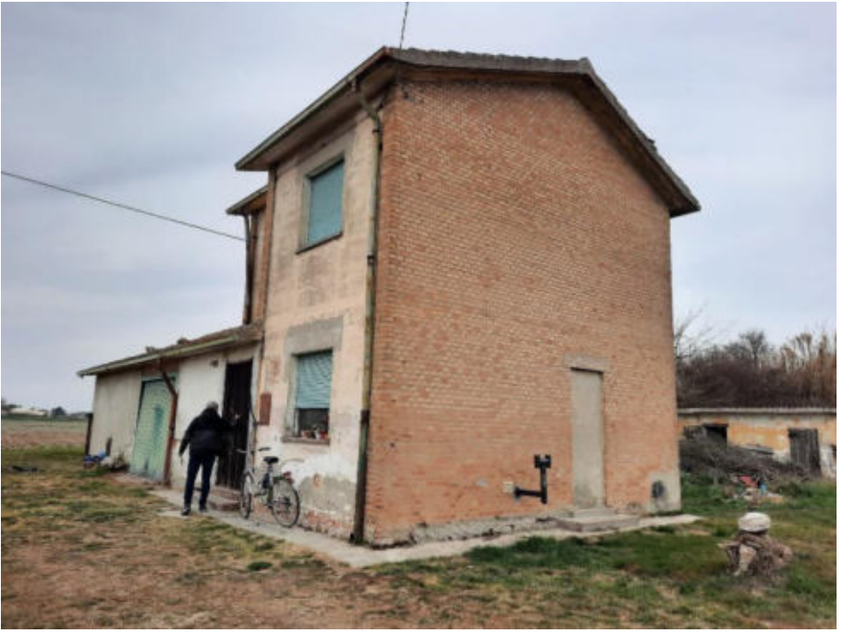
Figura 13. Foto Fonte: Regione Emilia-Romagna – sopralluogo 2022
