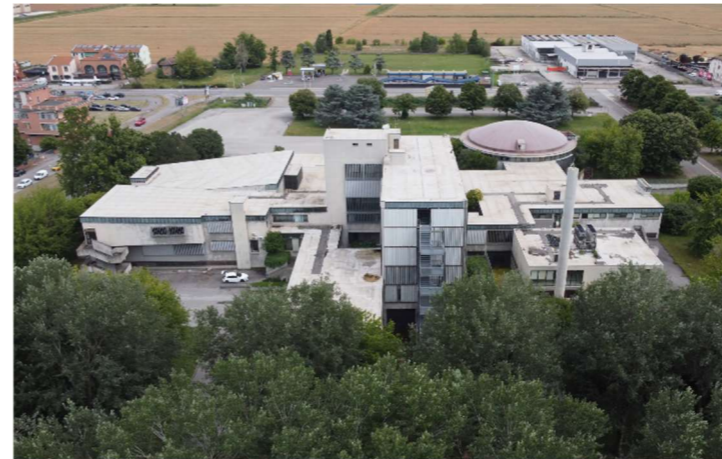
Figura 20. Foto Part. 11 (palazzina ex C.O). Fonte: : Regione Emilia-Romagna sopralluogo 2023
