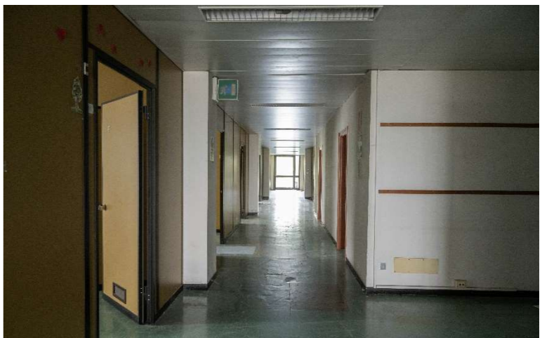
Figura 22 Part.11 (palazzina uffici ex COO). Fonte_Regione Emilia Romagna sopralluogo luglio 2023
