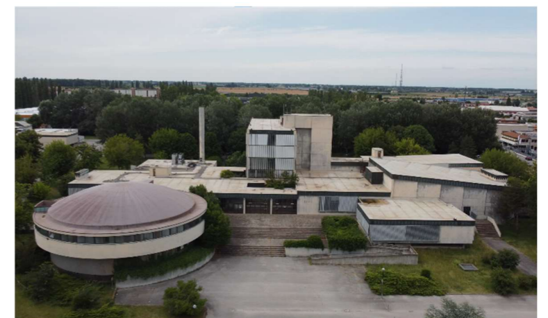
Figura 21. Foto Part. 11 (palazzina ex C.O). Fonte: : Regione Emilia-Romagna sopralluogo 2023
