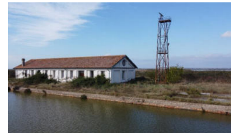
Figura 3. Ex SIVALCO Fonte: Regione Emilia – Romagna sopralluogo 2023
