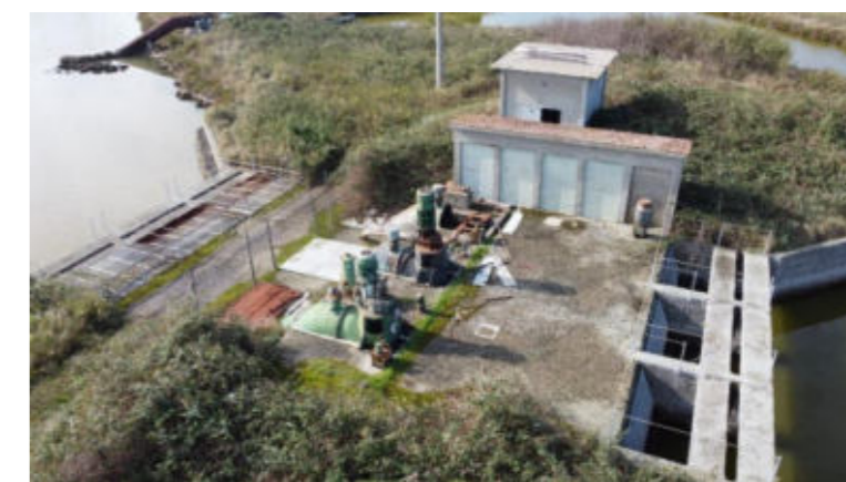
Figura 5. Ex SIVALCO Fonte: Regione Emilia – Romagna sopralluogo 2023
