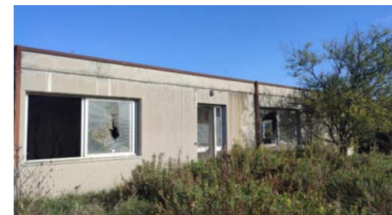
Figura 6. Ex SIVALCO Fonte: Regione Emilia – Romagna sopralluogo 2023
