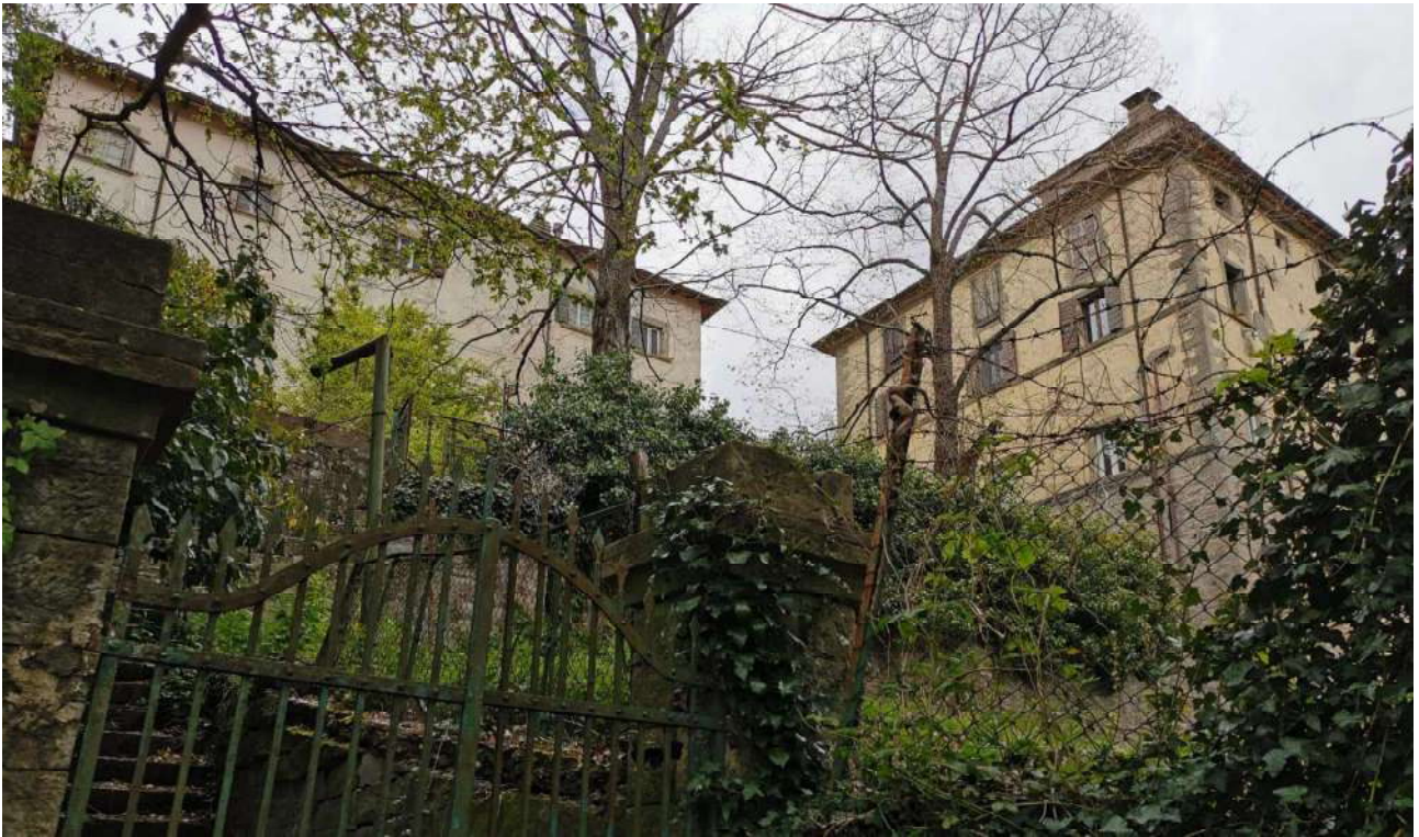
Figura 3_Palazzo Zanetti visto dal terreno a valle del fabbricato
