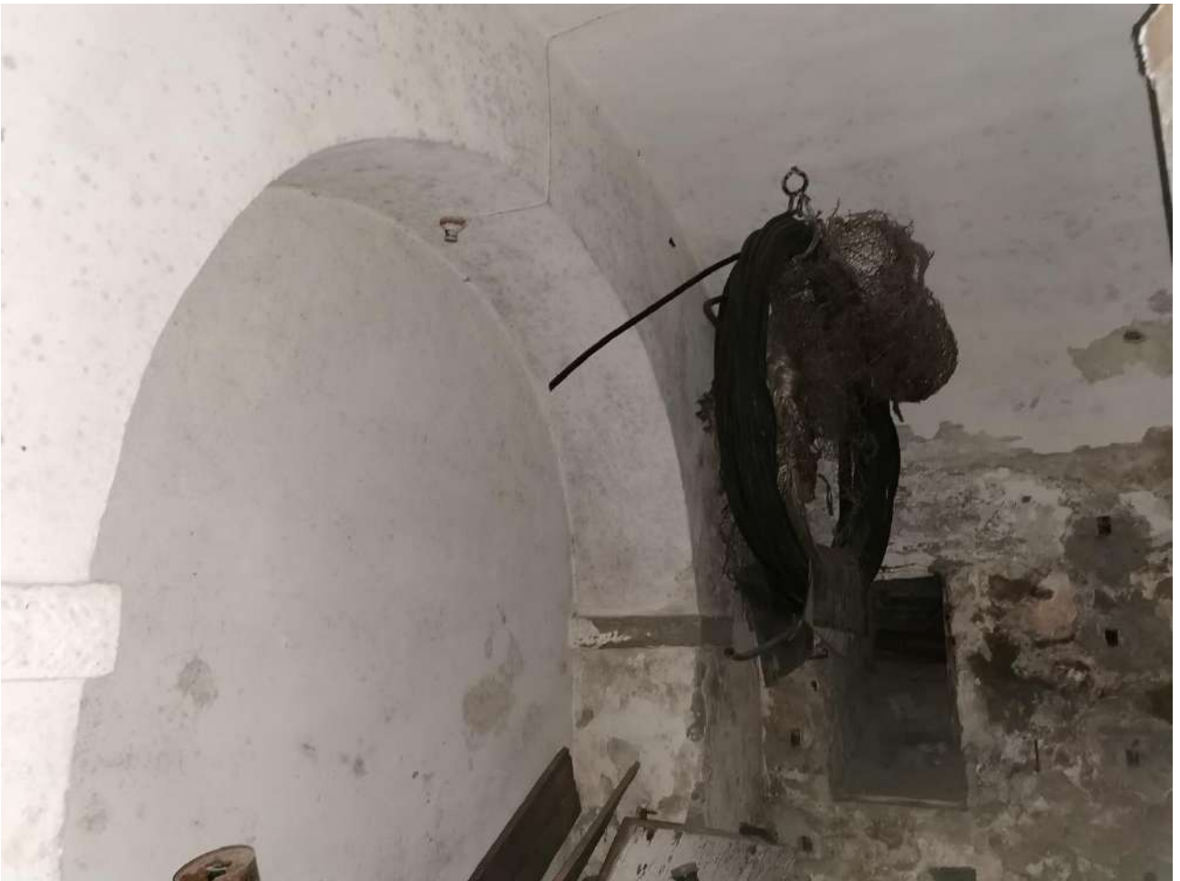
Figura 4_la cantina al piano -2
