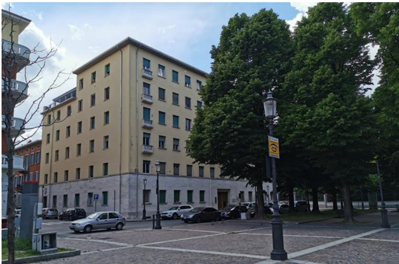
FOTO 1 . Lo stabile visto da Piazza Matteotti
