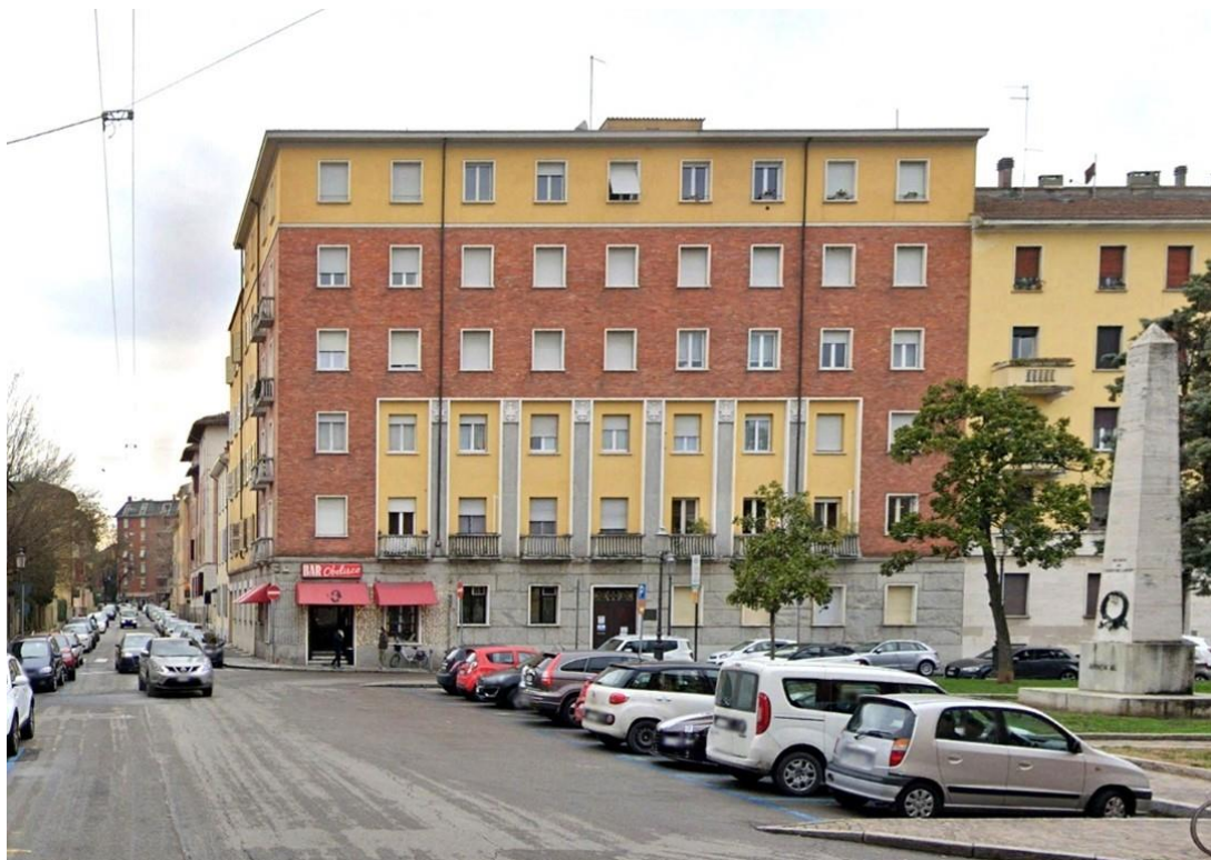
FOTO 1 . Lo stabile visto da Piazza Matteotti
