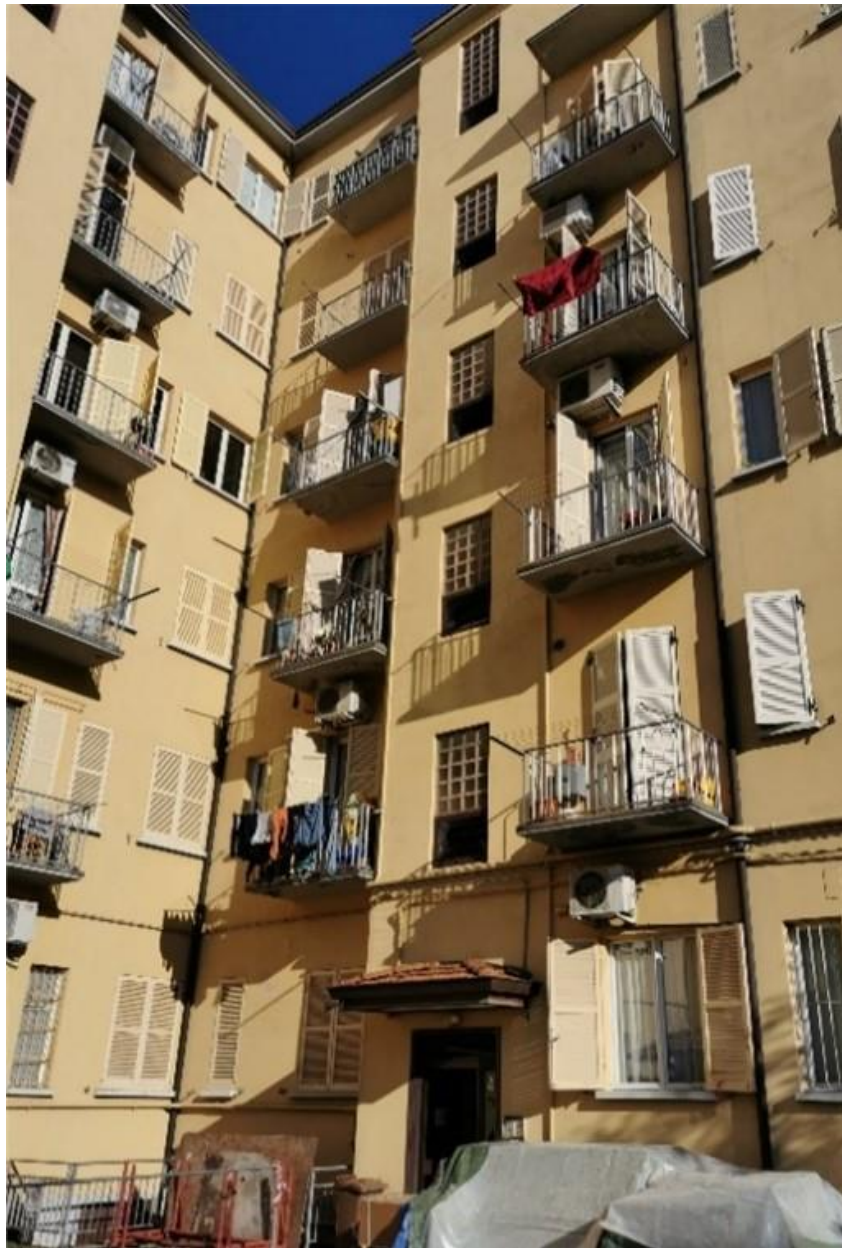
FOTO 2 . Lo stabile visto dal cortile interno
