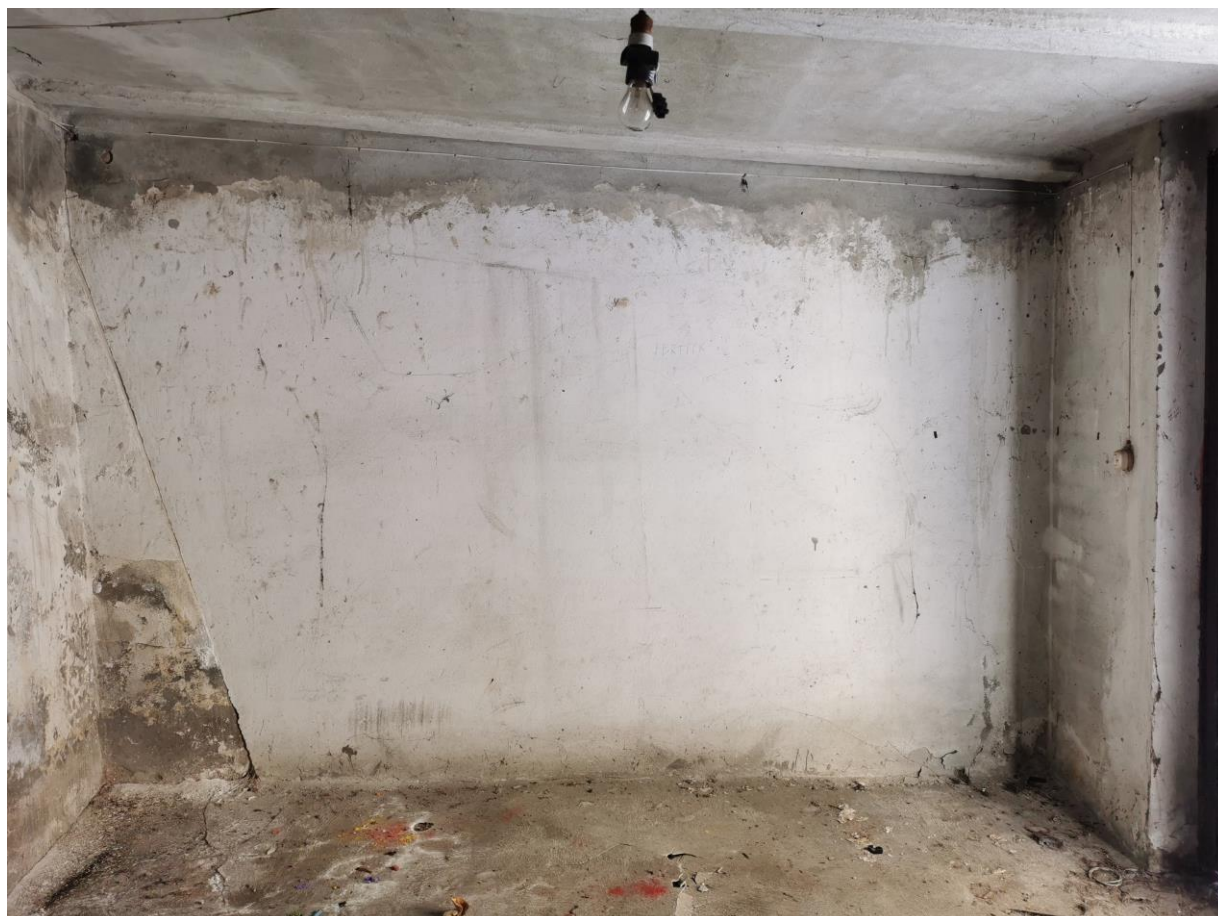
FOTO 13_ L'interno del garage
